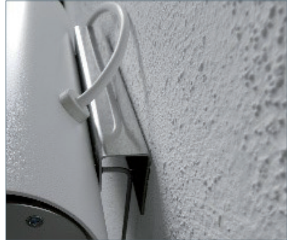
Fig. 7: Gerät in Wandhalterung einhängen.
